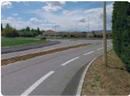
Noue de collecte des eaux de pluie, chemin des Fontaines.
